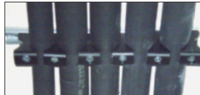
Comparativa de Instalación realizada con 5 tubos de PVC de 40mm.
